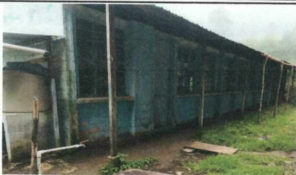
Foto 7: PISOS: Al momento de mejorar el área de la cocina que iniciaron los padres de familia con anterioridad, se necesitaba una cuneta para que el agua corra, por lo que se colocará una rejilla de metal.
