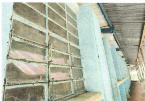
Foto 5: VENTANAS. La ventana de la bodega de los alimentos está en mal estado e incluso están algunos vidrios quebrados.
