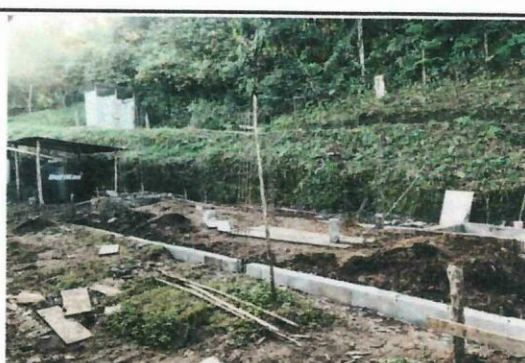
Foto 10: REPARACIÓN O SUSTITUCIÓN DE COCINA: Los padres de familia con sus propios recursos económicos iniciaron la construcción de una cocina que se quedó inconclusa, por lo que consideran oportuno continuarla.
